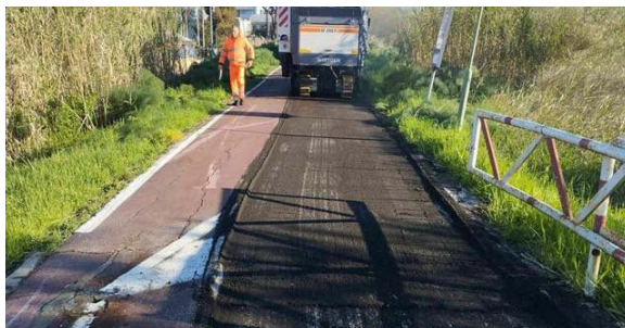
Lavori di riqualificazione della pista ciclopedonale Castel Giubileo-Ponte Milvio che collega il III Municipio con il XV Municipio
