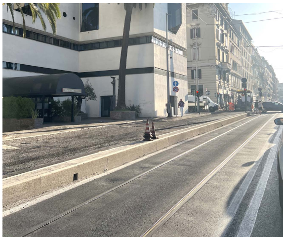
Il ripristino dell'asfalto di via Labicana, in seguito ai lavori di Areti per gli allacci della metro C
